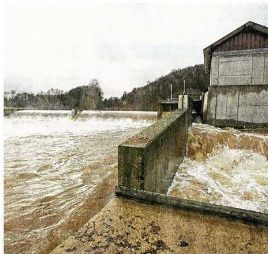
Hier, am Cainsdorfer Wehr, braute sich am Samstagmorgen zusammen, was einige Hundert Meter weiter flussaufwärts zur Überflutung eines Firmengeländes führte. Das Wehr war nicht weit genug abgesenkt. FOTO: RALPH KÖHLER
